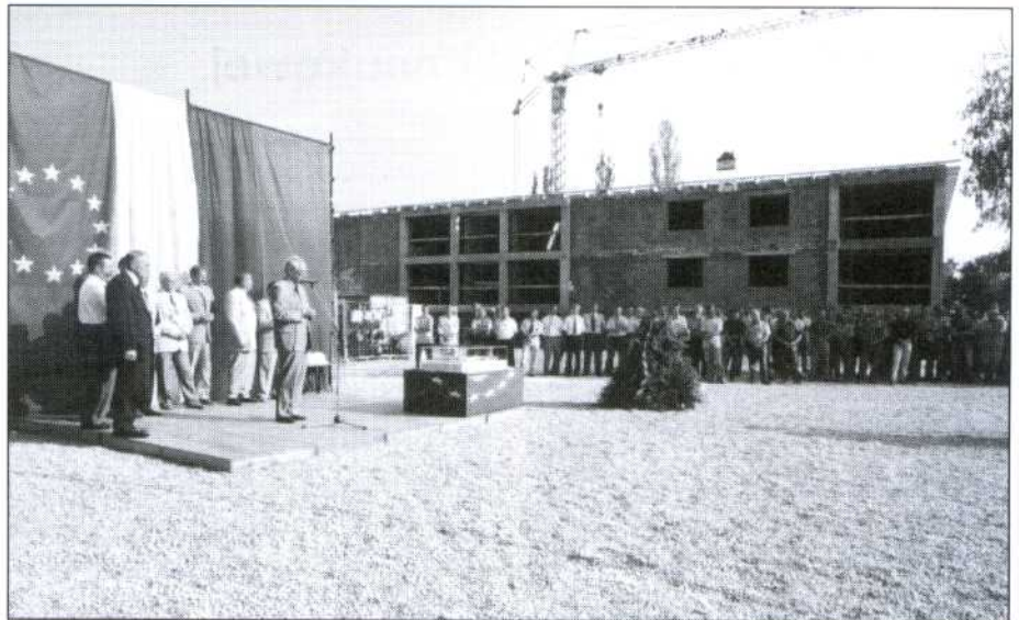
Wiecha na budowie Kolegium, 29 sierpnia 2002 r.
