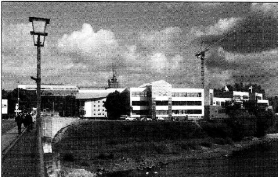
Most słubicko-frankfurcki. Widok na Collegium
