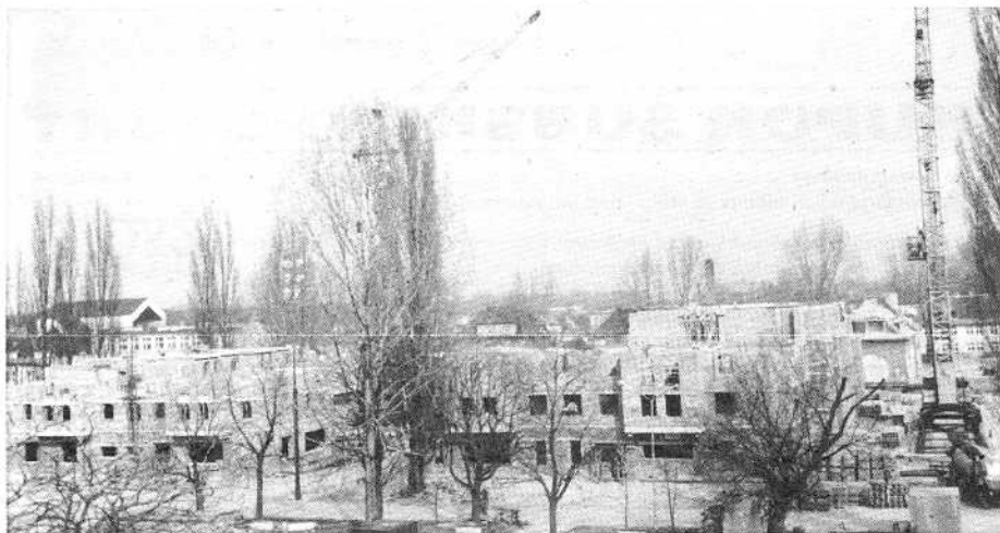
Plac budowy w Słubicach. Fot. Teresa Lipka
