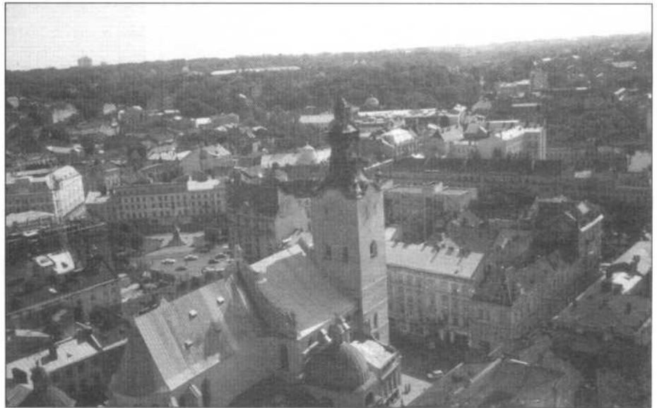
Katedra rzymsko-katolicka we Lwowie; widok z wieży ratuszowej
