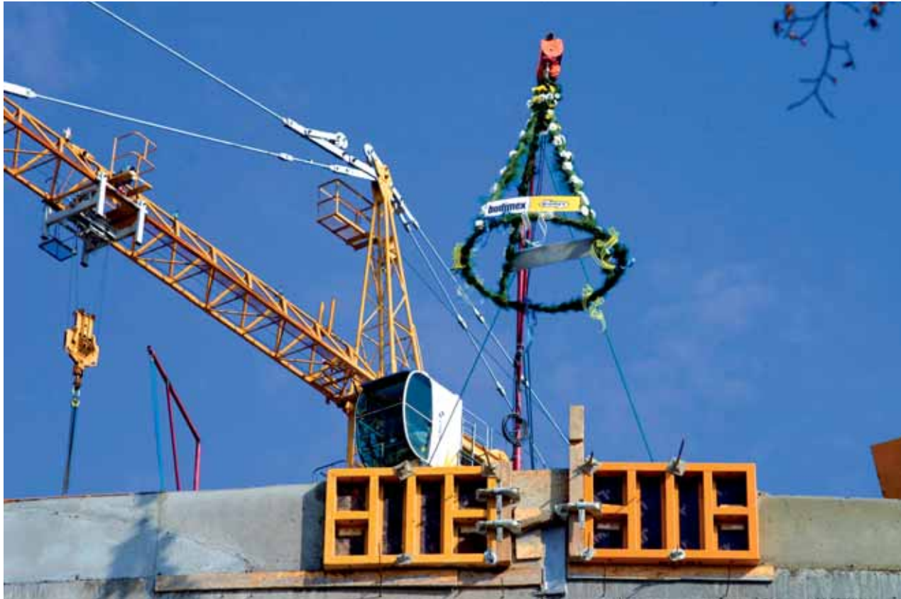
Budynek dydaktyczny Wydziału Pedagogiczno-Artystycznego w Kaliszu jest pod dachem, o czym zaświadcza triumfalna „wiecha”
