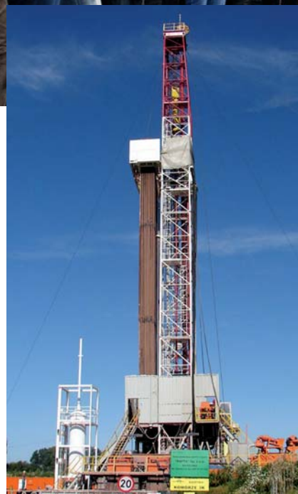
Poszukiwanie nowego z ołża gazu ziemnego – wiercenie otworu Komorze-3K
