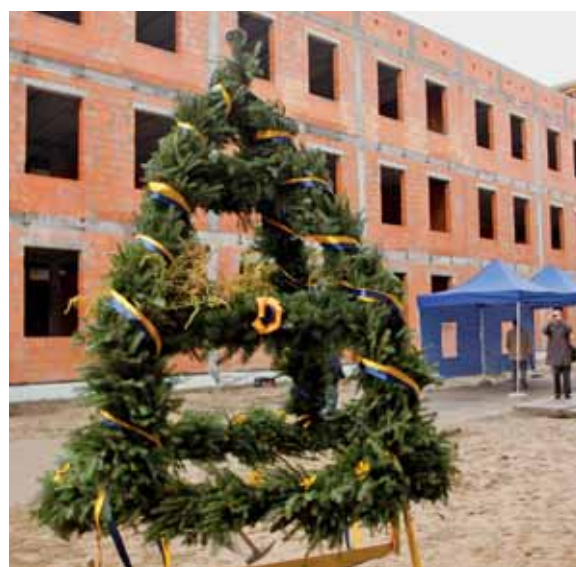
Nad murami budującej się siedziby Wydziału Chemii zawisła tradycyjna wiecha. A to znaczy, że chemikom do Moraska... coraz bliżej
