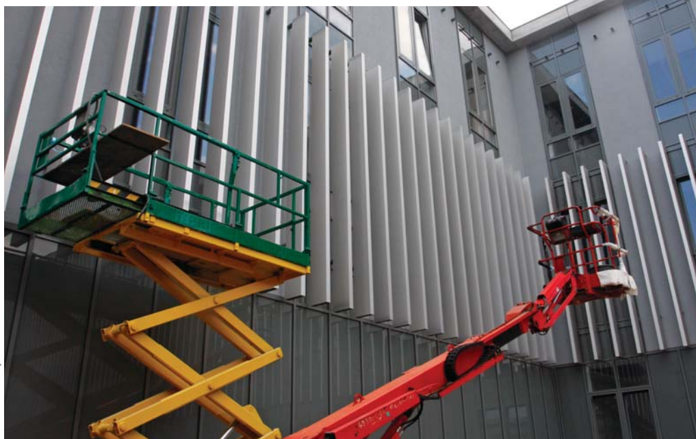
Powstaje fasada dziedzińca nowego budynku Wydziału Historii na Morasku
