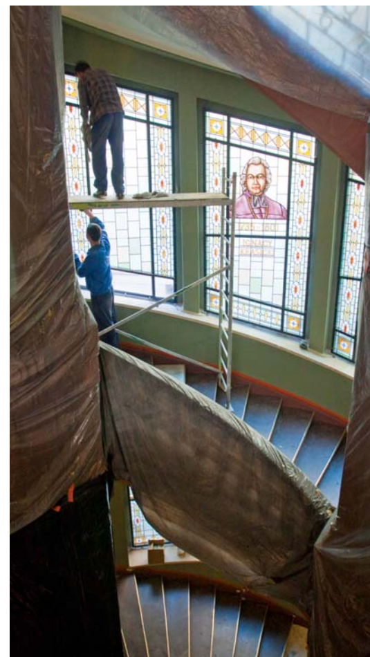
Remont klatki schodowej w Collegium Maius
