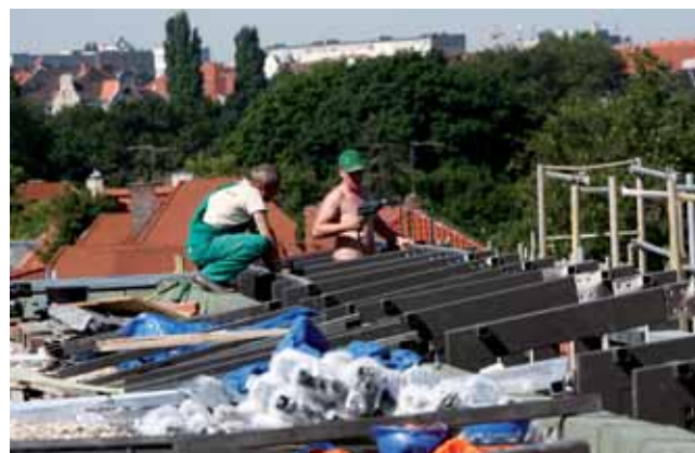
Na budowie Wydziału Prawa i Administracji
