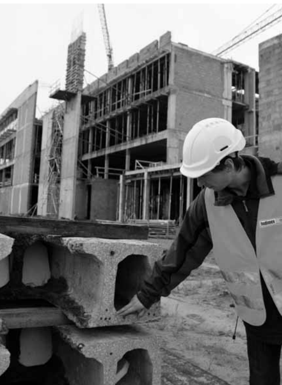
Budowa nowej „Chemii” i „Prawa”
